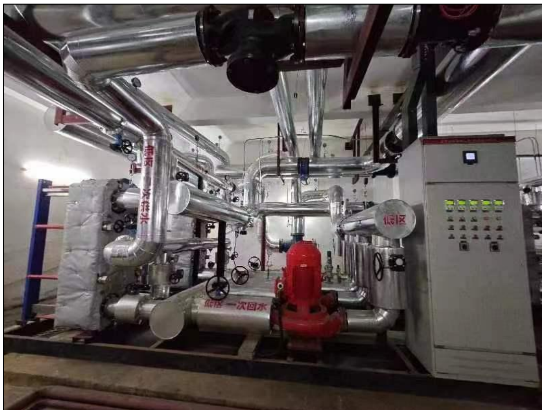
图4-2 热交换站设备基础减振
