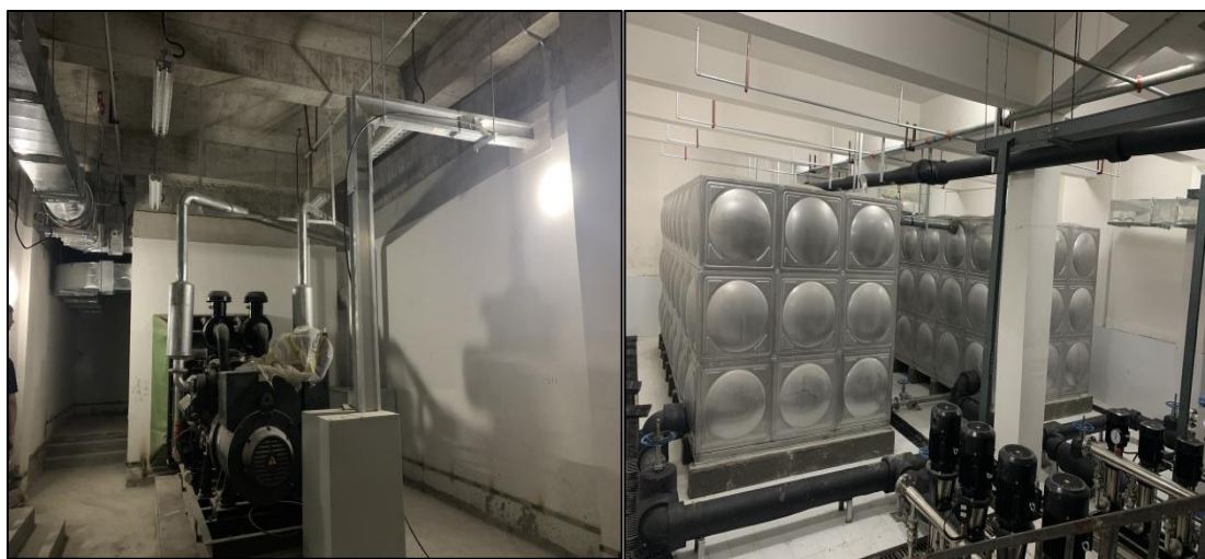
图4-3 备用发电机、水箱设备基础减振
