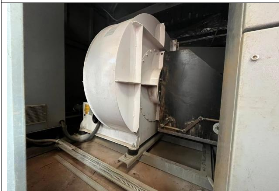
设备基础减震、设备与管线之间用弹性元件连接
